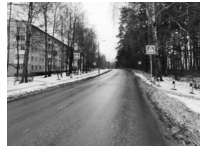
12 Отсутствие тротуара у примыкания территории к проезжей части улицы
