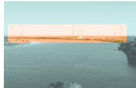
3 Воздушный переход ВЛЭП с доминантами — опорами ВЛЭП
