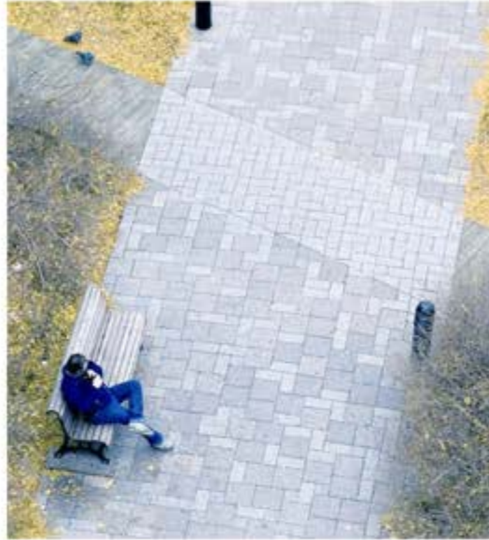
ТРОТУАР Бетонная плитка
