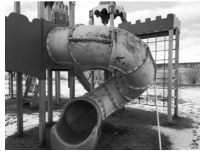
3 Изношенное состояние детского городка
