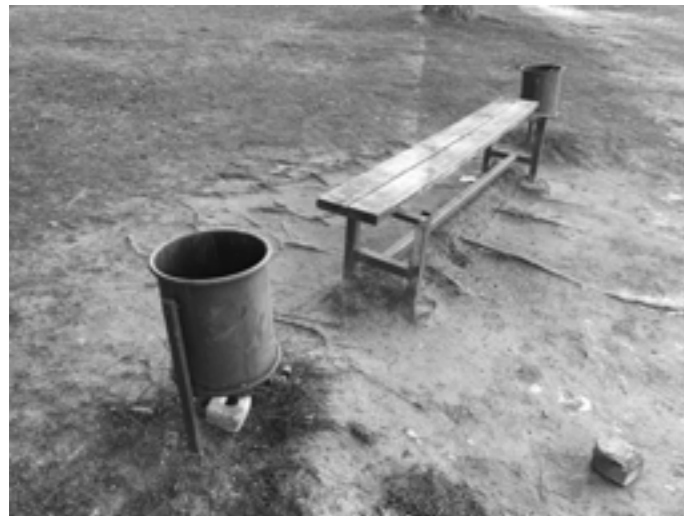
1 Изношенные, фактически разрушенные камейки и урны
