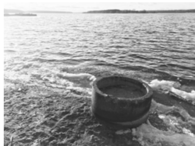
10 Зброшенне железобетонные конструкции на территории пляжа
