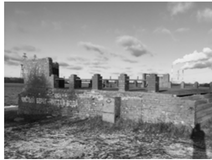
2 Аварийное состояние прибрежной сцены
