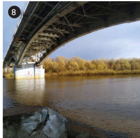
8 Красивые опоры моста.
