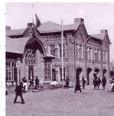
5. Ярмарочное пожарное депо, ул. Стрелка, 19, литер А
