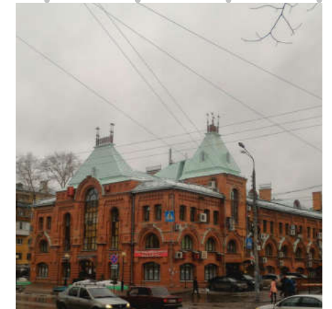
9. Корпус мануфактурных складов Нижегородской ярмарки, ул. Мануфактурная, 14 (литеры Б, Б1)
