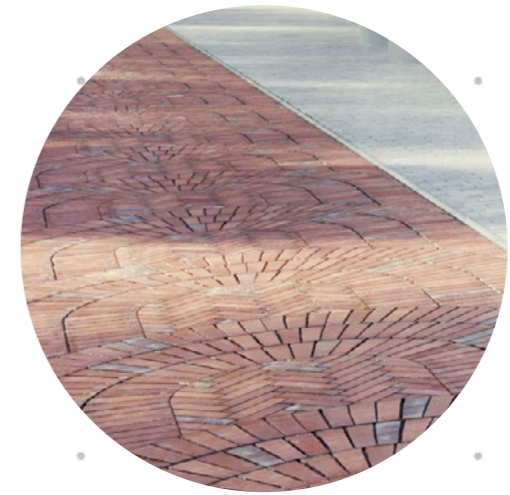
Мощение из кирпича с арочным рисунком — отсылка к Ярмарочной сводчатой кирпичной канализации 19 в.
